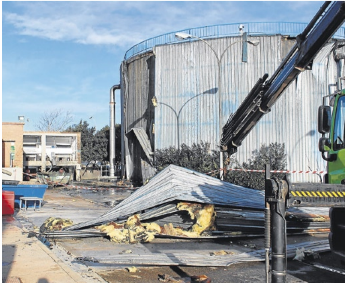
Averiado. El digestor de fangos de la depuradora de La Almozara, que se averió la semana pasada.
