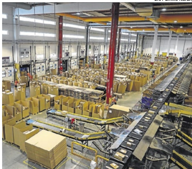
Automatizada. Planta de Amazon en Torrejón de Ardoz (Madrid).
